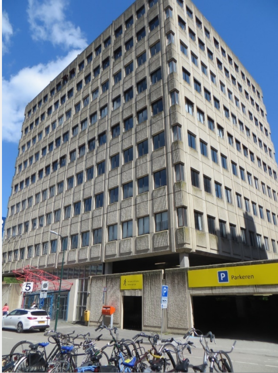
Figuur 5.9 Parkeergarage onder Bisonspoor
