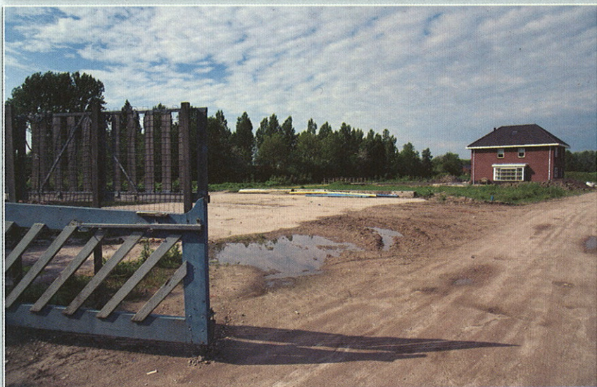
Nieuwbouw in Delfzijl - Holwierde komt soms moeizaam tot stand. (MINISTERIE VROM, ROB POELNJE)
