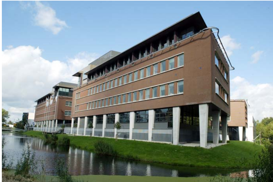
Onderhoud op de Goudse Poort
