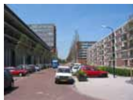
RENOVATIE EN NIEUWBOUW AAN DE KLAAS KATERSTRAAT
