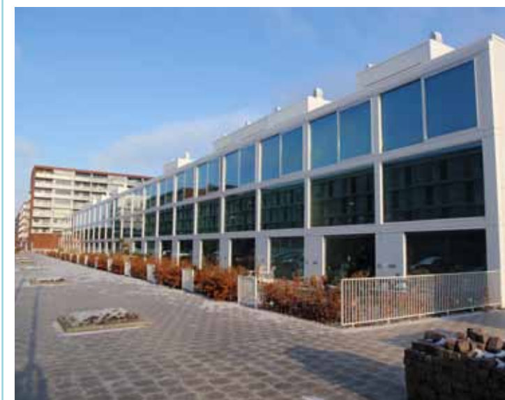
EENGEZINSWONINGEN AAN DE DOMELA NIEUWENHUISSTRAAT, DEELGEBIED D
