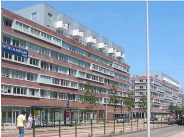
NIEUWBOUW AAN DE PIETER CALANDLAAN
