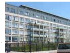
RENOVATIE EN OPTOPPING AAN DE HERTINGENSTRAAT
