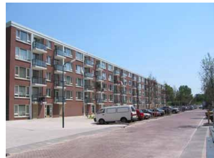
HET GERENOVEERDE COMPLEX VAN WONINGCORPORATIE PWV AAN DE KLAAS KATERSTRAAT
